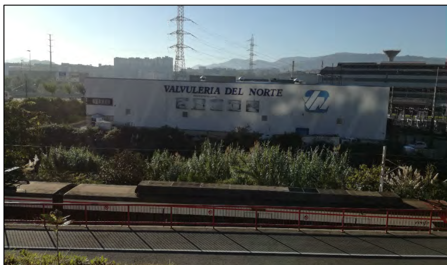
Nave industrial de Valvulería del Norte S.L. al norte de las AIS-Las Canteras
